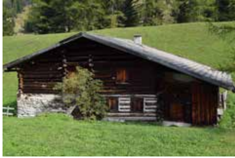
Die historischen Bauernhöfe in Pfafflar wurden aus Rundholzblöcken errichtet und mit Lehm verputzt
